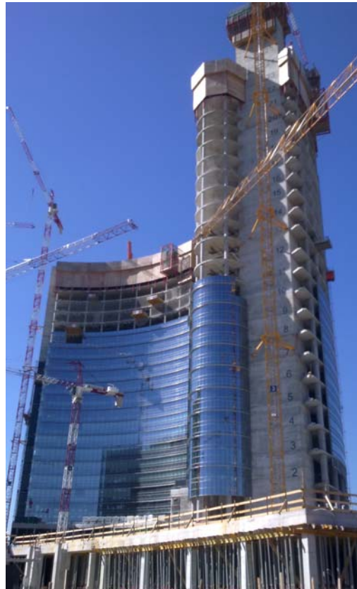
Figura 12 Particolare della fase di completamento della Torre A
