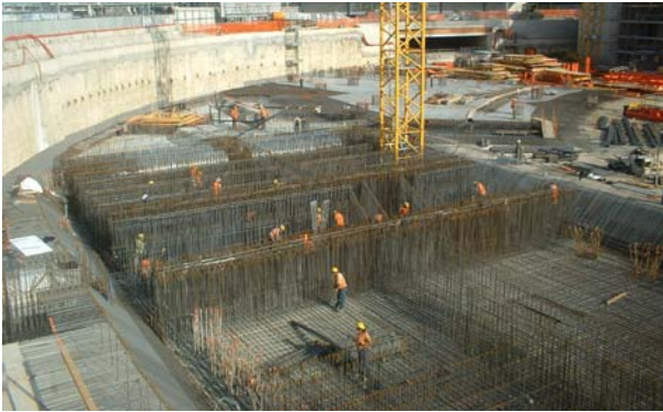
Figura 10 Particolare della fase di realizzazione della platea
