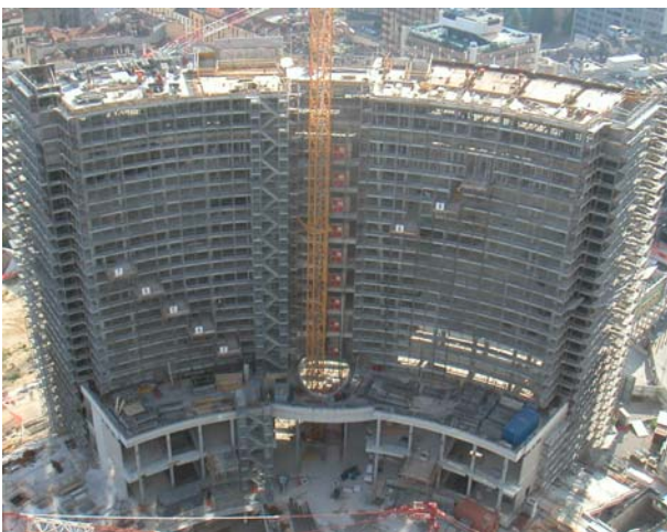
Figura 11 Particolare della fase di completamento della Torre C
