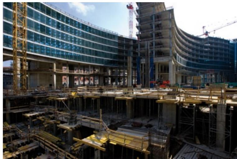
**LA FORMA CURVA DELL'EDIFICIO HA IMPOSTO UN'ATTENZIONE PARTICOLARE IN FASE COSTRUTTIVA: L'EDIFICIO RICHIEDE NUMEROSI PEZZI SPECIALI CHE RACCORDANO PORZIONI DI GEOMETRIE STANDARDIZZATE CON ELEMENTI CHE VENGONO FORNITI SULLA BASE DI UN CASELLARIO CHE VIENE RILEVATO IN FASE DI CANTIERE, MESSO IN PRODUZIONE E POI POSTO IN OPERA.**
